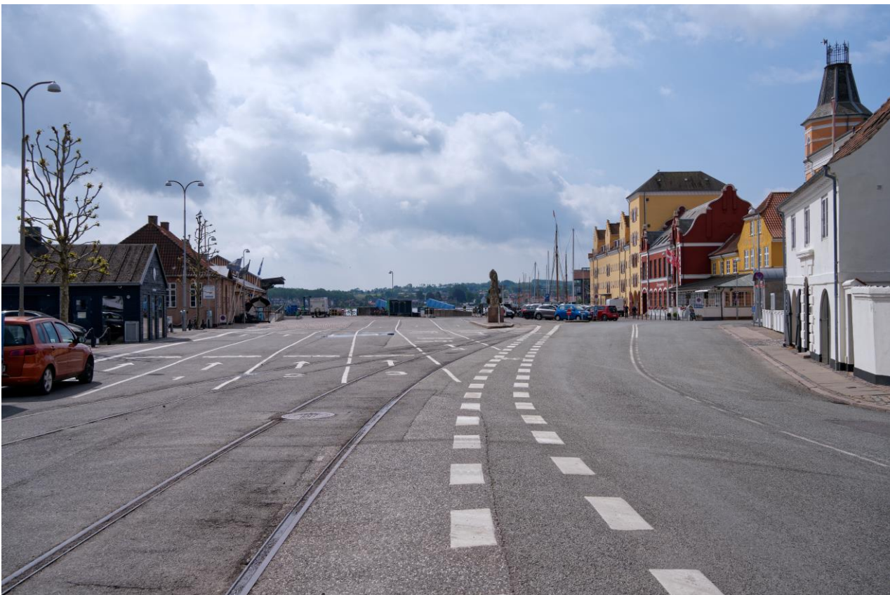
Figur 7: Standpunkt 2: Fra nord mod syd – referencefoto af eksisterende forhold.
